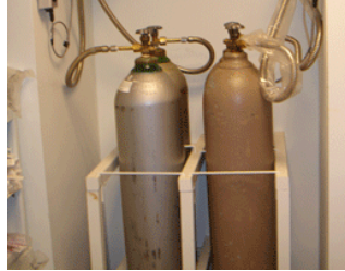
รูปที่ 2.2 ตัวอย่างการวางถังแก๊สที่เหมาะสมในห้องปฏิบัติการ
