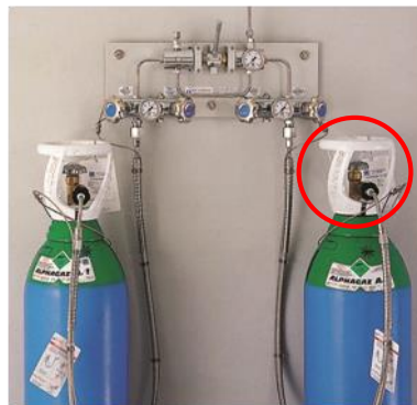
รูปที่ 2.3 ตัวอย่างถังแก๊สที่มี guard ป้องกันหัวถัง ขณะใช้งาน
